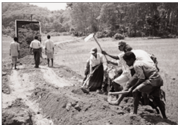
Construyendo el camino a Ratnapura, las comunidades van forjando sus propias soluciones, Sri Lanka
